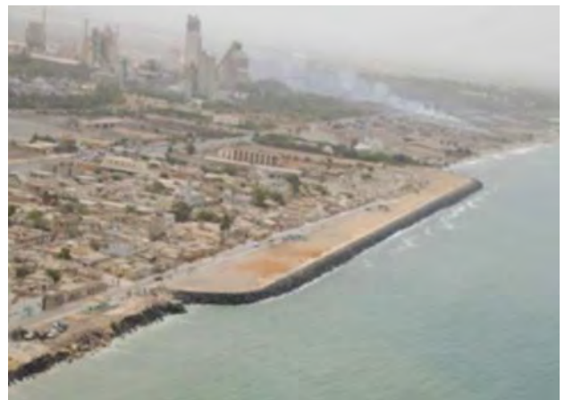
Photo 22 : Enrochements à Bargny (2)
