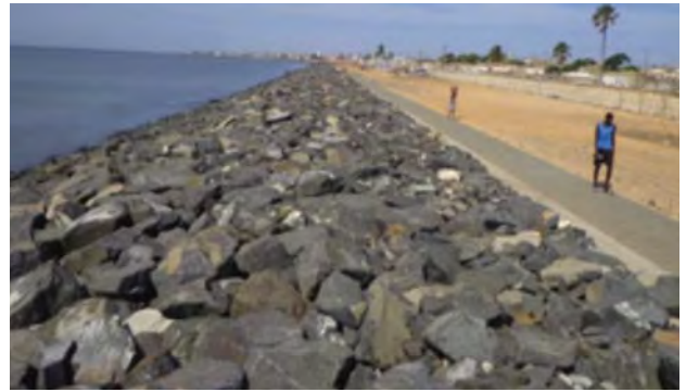
Photo 21 : Enrochements à Bargny (1)
