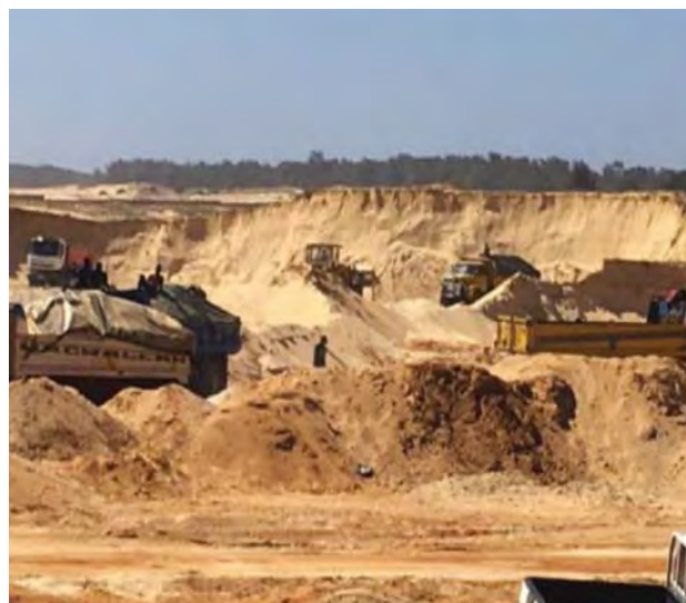
Photo 35 : Extraction massive du sable marin
