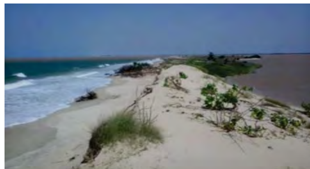
Photo 27 : Le sud de la nouvelle brèche ouverte en octobre 2013 (1)
